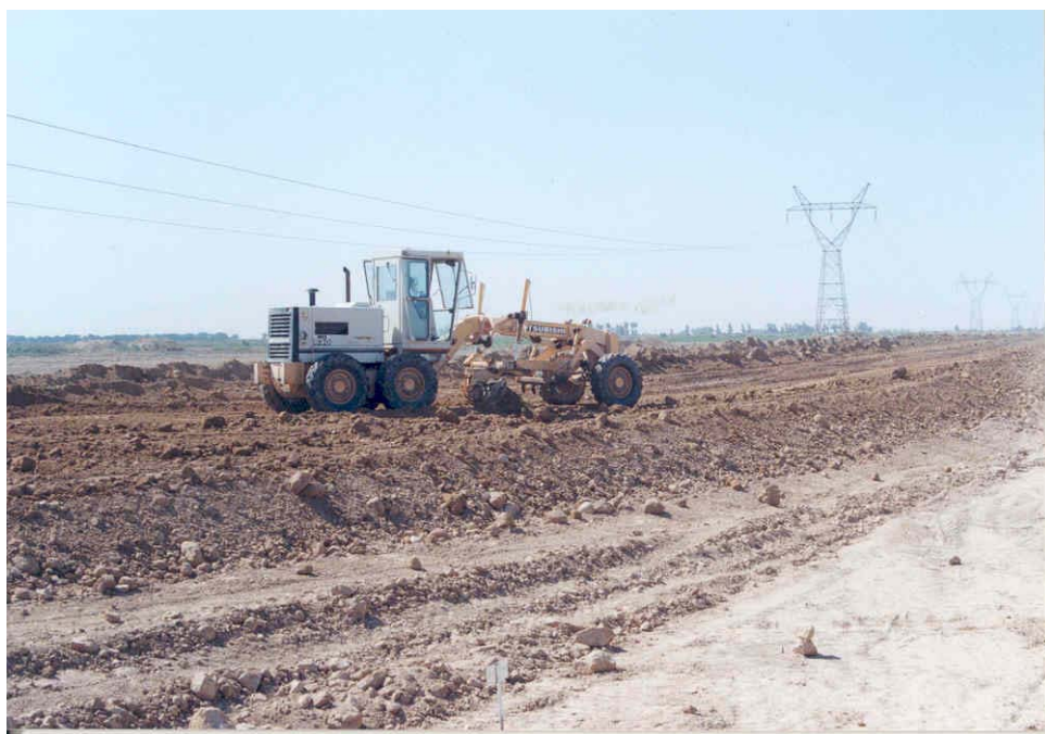
استفاده از آهک جهت تثبیت بستر راه
